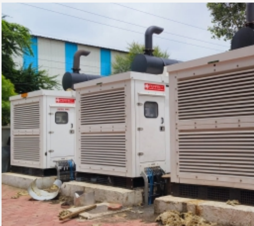
Extreme Interiors of NE India 1250 kVA x 4
